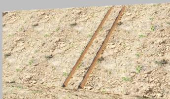
Poser la Single-Step sur les bois équarris et les fixer latéralement de chaque côté avec au moins un clou ou une vis.
