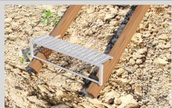
Fixation au bois équarri avec au moins un clou ou une vis par patte.
