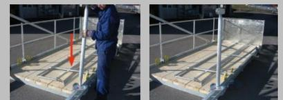
Monter les tirants à l'aide des vis à levier livrées. Les vis doivent toujours être serrées à fond, quelle que soit la position indiquée par le levier.
