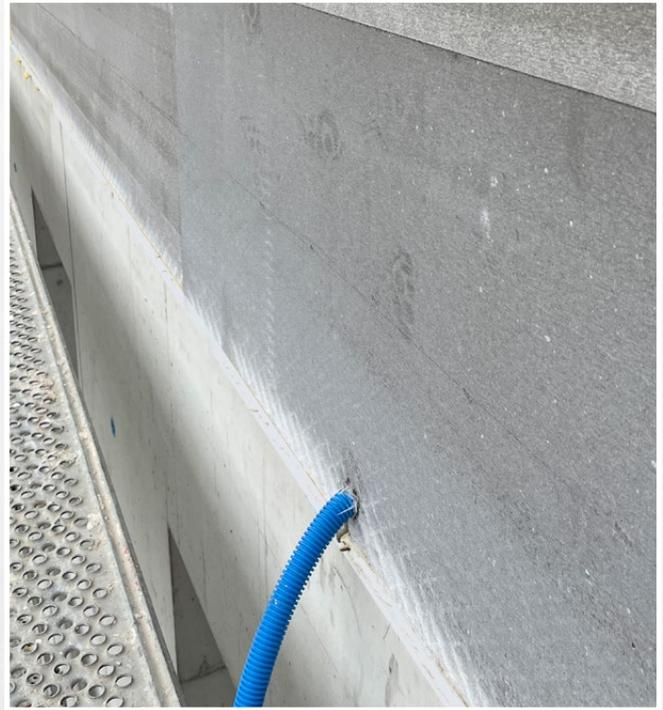
*Il est également possible de percer l'élément Bordfix pour réaliser des traversées...*
