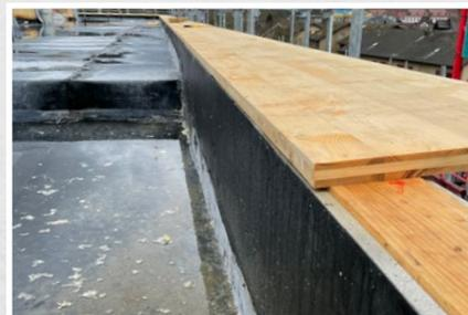
Le pare-vapeur et l'étanchéité de la toiture plate peuvent être réalisés parfaitement sur l'élément d'acrotère
