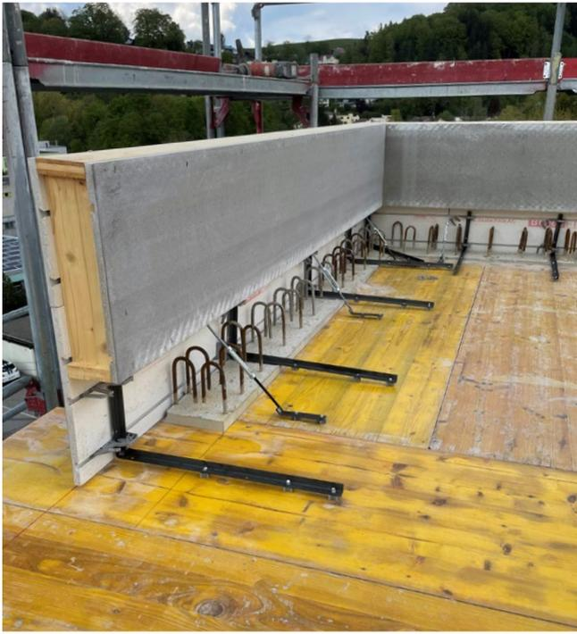
*Pour que la hauteur soit adaptée au montage, une plinthe peut être posée au préalable sur la dalle inférieure lors du bétonnage du mur*
