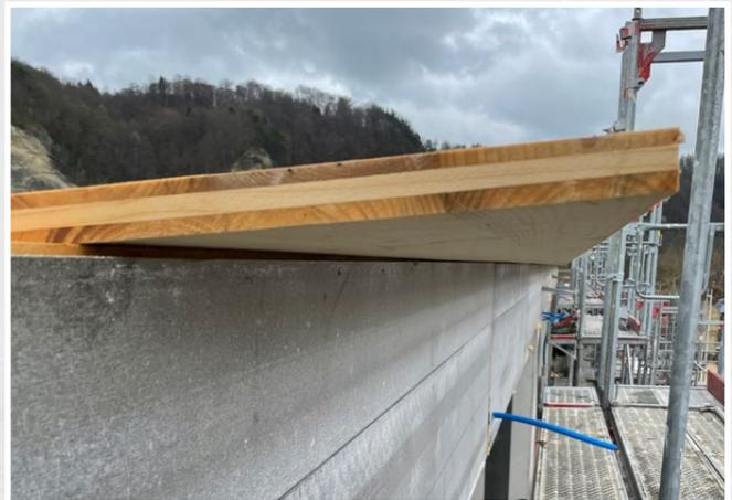
*Une planche de couverture peut être vissée directement sur l'élément d'acrotère Bordfix avec une pente intérieure de 4°*
