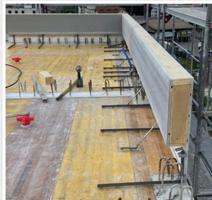
Aligner aisément avec les crochets de fixation
