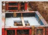
Les réservations TBA plus grandes que le coffrage intérieur ou extérieur doivent être étayées par des moyens conventionnels. La dimension de la réservation à partir de laquelle un étaie est nécessaire est indiquée au point «Caractéristiques techniques - Diagramme d'étaie».
