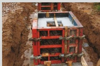
Réservation TBA bétonnée comme coffrage intérieur et extérieur
